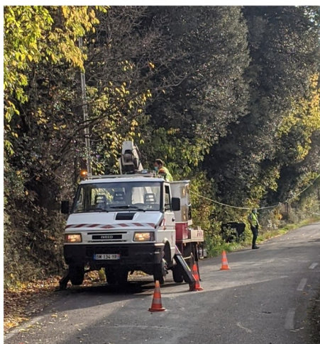
Réparation de l'alimentation électrique d'un lampadaire Route de la Croix des Vents.
